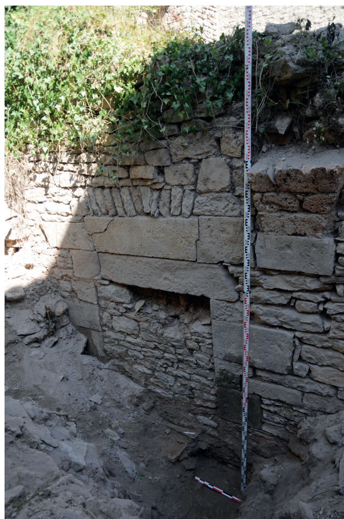
Fig. 1 : Sévérac-d'Aveyron, Château. Cheminée et départ de voûte mis au jour dans la pièce ouest (G. Malige).
