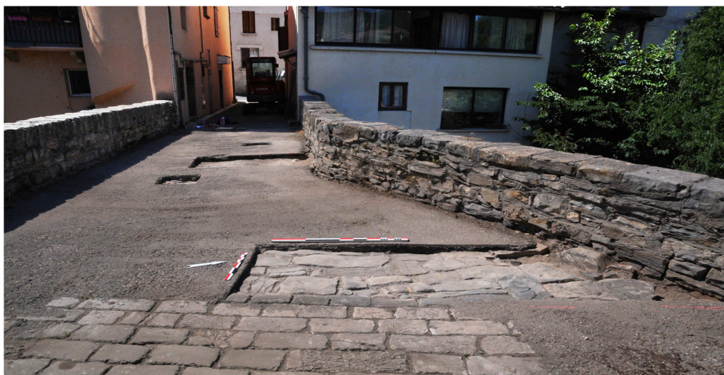
Fig. 2 : Implantation des sondages réalisés sur le Pont-Vieux à Millau avec apparition d'une des chaussées ancienne.
