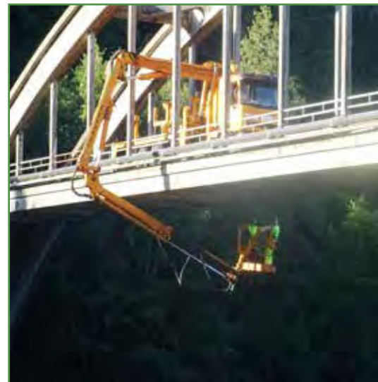
Inspection avec une nacelle de la sous face du tablier du Pont de Port d'Agres, sur la rivière Lot
