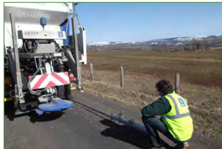
Mesure de la déflexion de la chaussée par le laboratoire départemental, en vue de dimensionner un éventuel renforcement structurel, dans le cadre de son renouvellement
