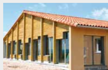
Le chantier de Belmont-sur-Rance
